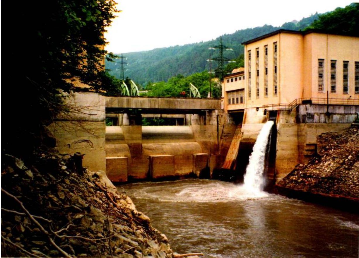
Figura 3: Foto della diga di Rio Pusteria (fonte: FCEM).
