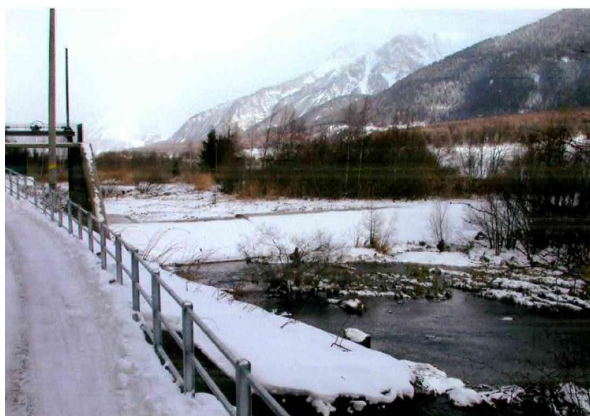
Figura 3: Foto della diga del Lago della Mutta (fonte: FCEM). Vista paramento di valle e di monte.
