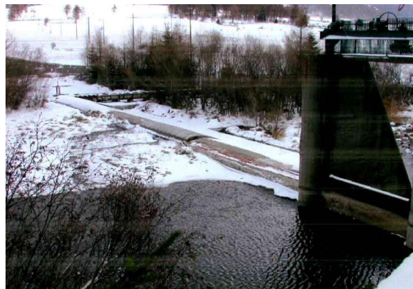
Abbildung 3: Fotos der Stauanlage Haidersee (Quelle: LHBI). Ansicht Staumauer luftseitig una bergseitig.
